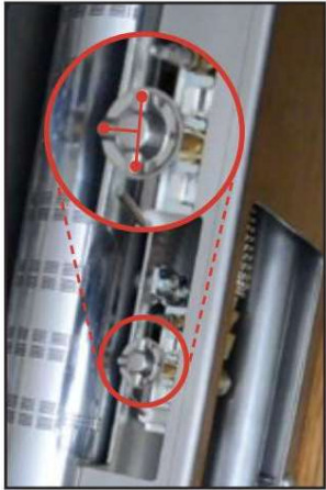
15 - Сброс пламени запальной горелки
